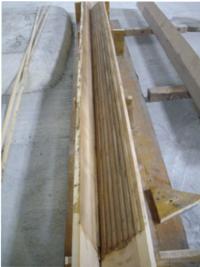
REALIZZAZIONE DEL CASSERO PER IL GETTO
